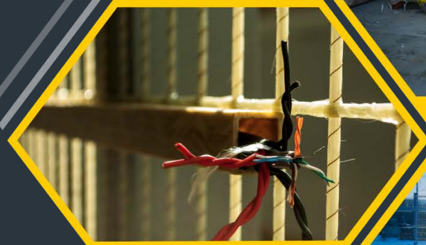
элементы жесткости - кабель-каналы
